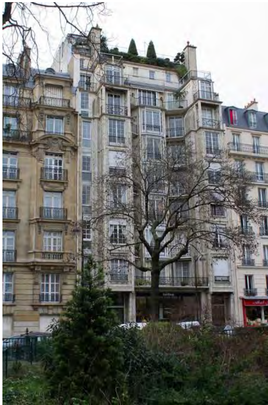
Immeuble de rapport, 25 bis rue Franklin à Paris
